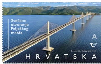
1. SVEČANO OTVORENJE PELJEŠKOG MOSTA
