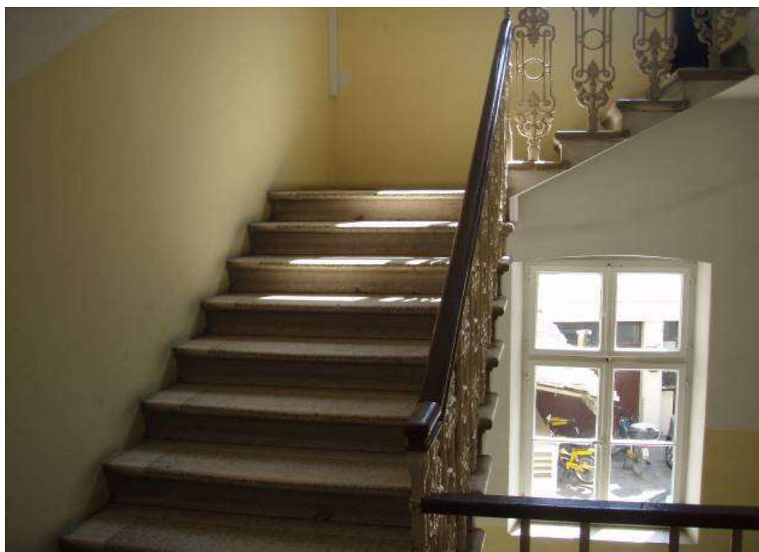
Stubište glavnog objekta
